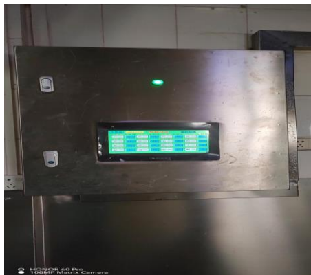
永旺厂一工程浸米间溢流水阀门改为时间控制;每天节约用水5.2T,年节约费用0.8万元
