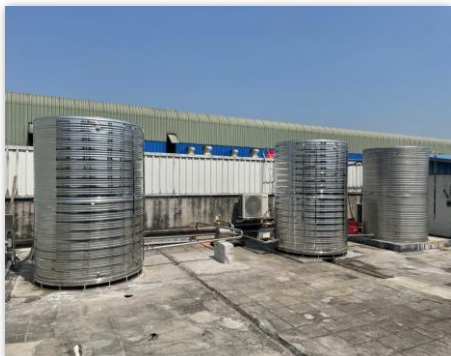
大旺厂蒸汽冷凝水回收使用改善;2022年1-11月回收水量6557吨,年节约费用2.20万元
