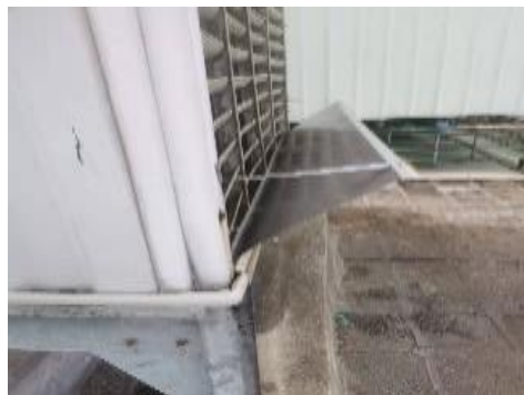
大旺厂冷却水塔增加挡水板改善;年节约费用0.2万元
